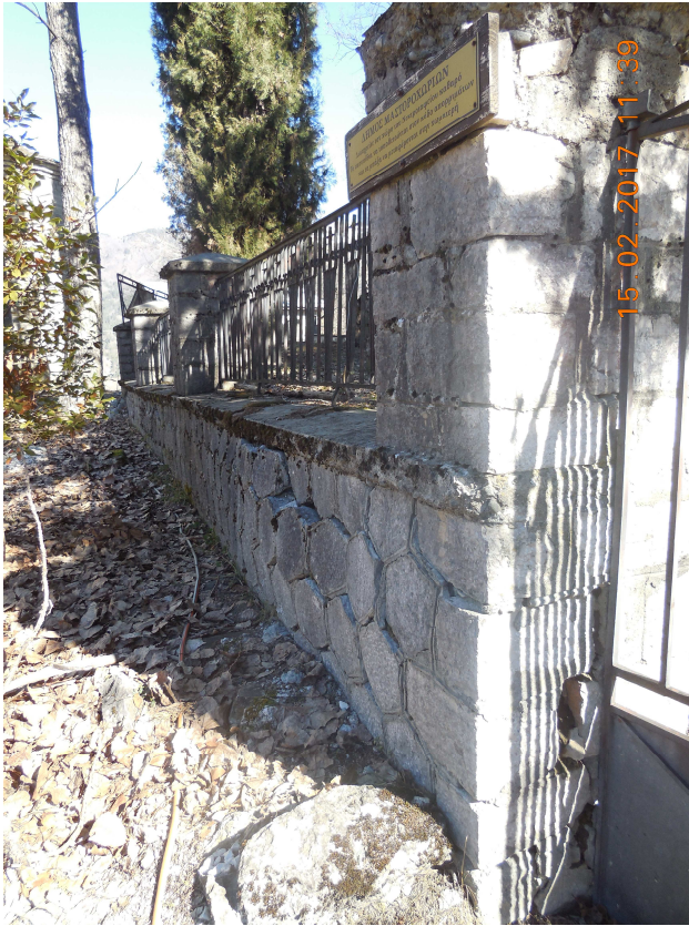
Άποψη του περιβόλου από τον αύλειο χώρο της γειτονικής εκκλησίας.
