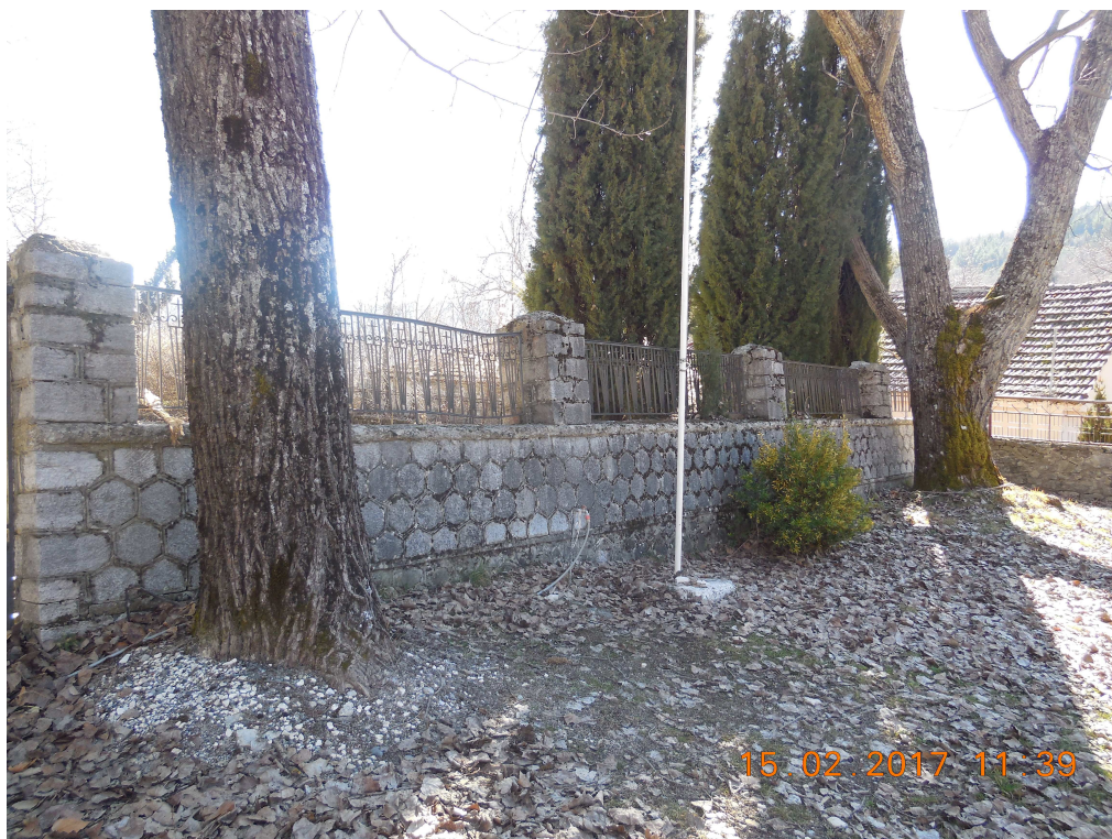
Άποψη του περιβόλου από τον αύλειο χώρο της γειτονικής εκκλησίας.
